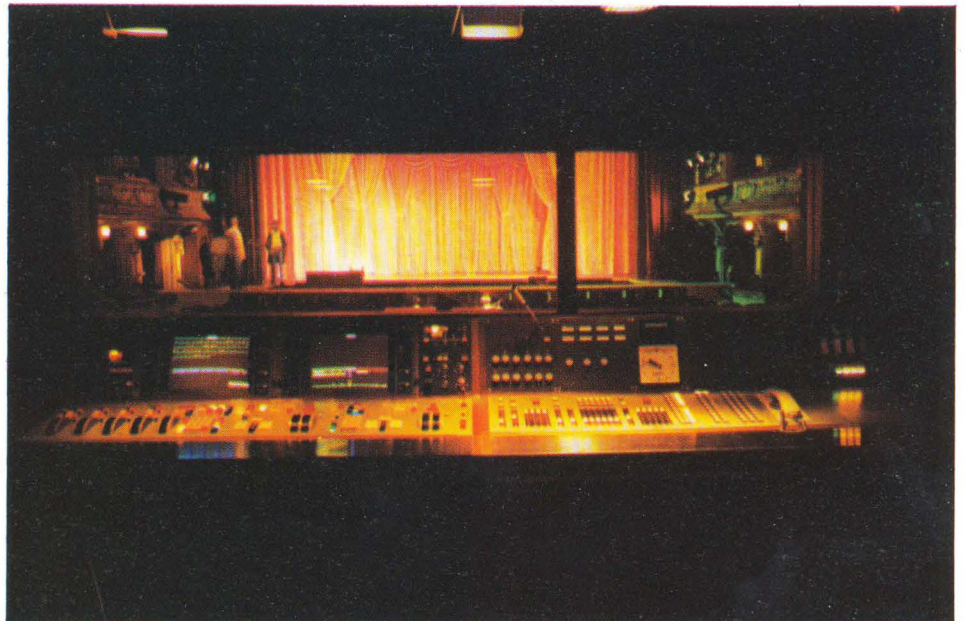
Lightboard Mark 2 control for 400 ways at Deutsches Schauspielhaus, Hamburg.
