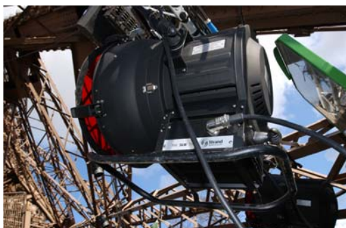
A close up view of one of the lights mounted inside the tower to illuminate the top half of the structure/ Vue rapprochée d'un projecteur intégré dans la structure de la tour afin d'atteindre la partie
