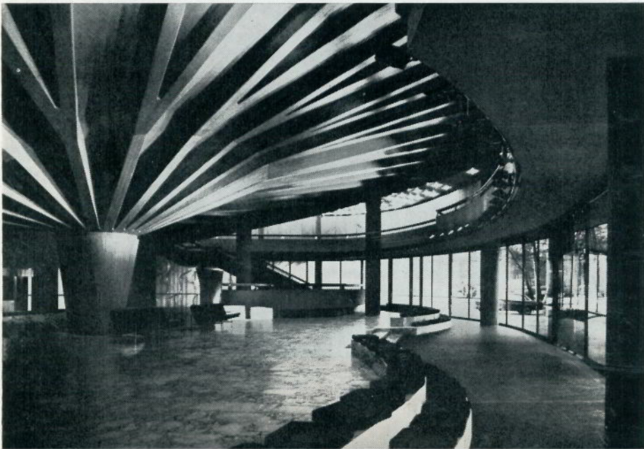
Düsseldorf Schauspielhaus: Underneath the spreading concrete tree.
